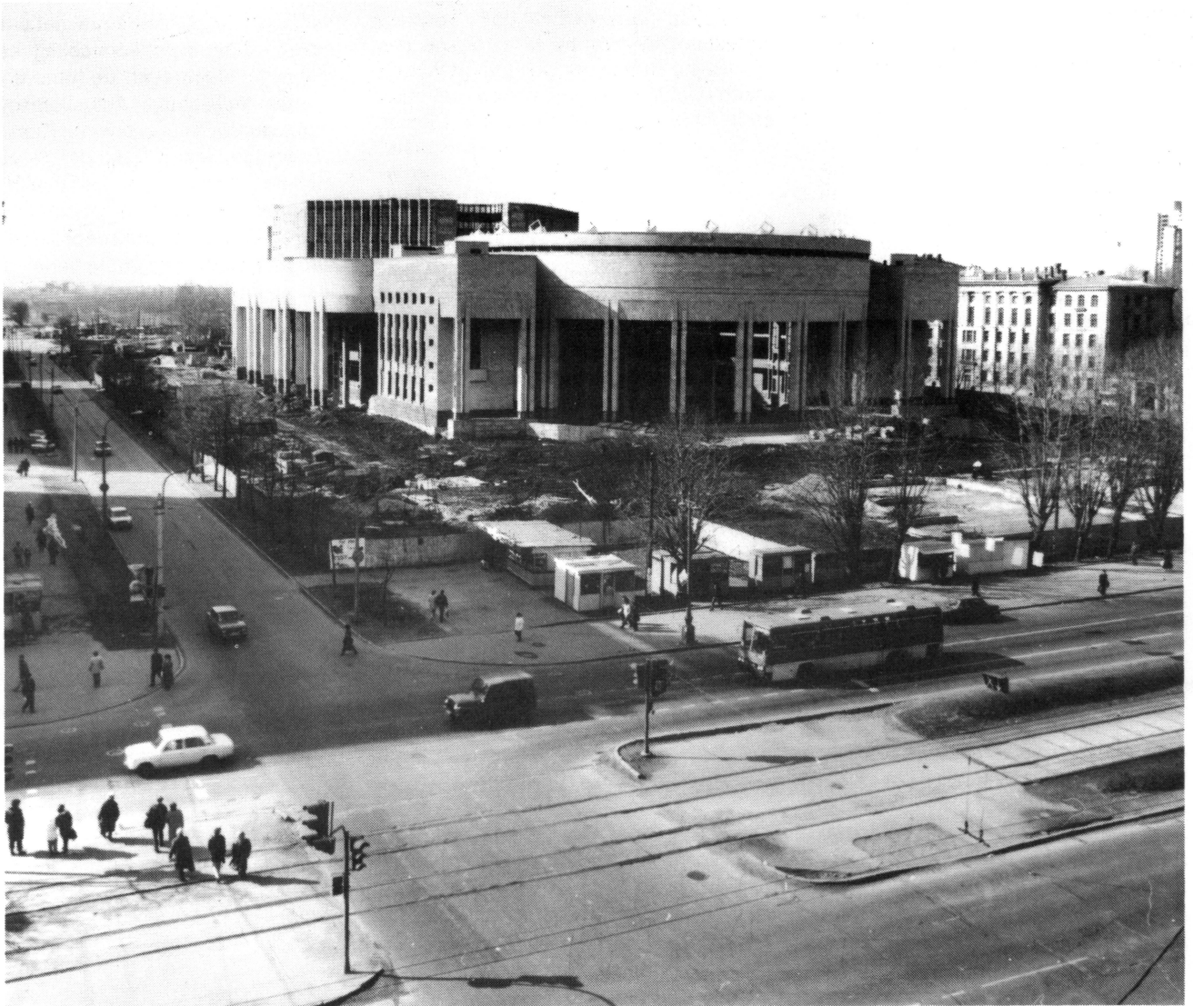
État des travaux de construction du nouvel édifice de la Bibliothèque nationale à Saint-Petersbourg.
