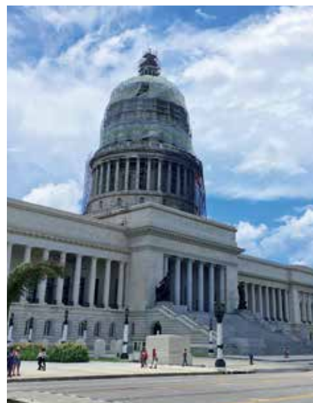
Capitole de La Havane durant sa restauration
