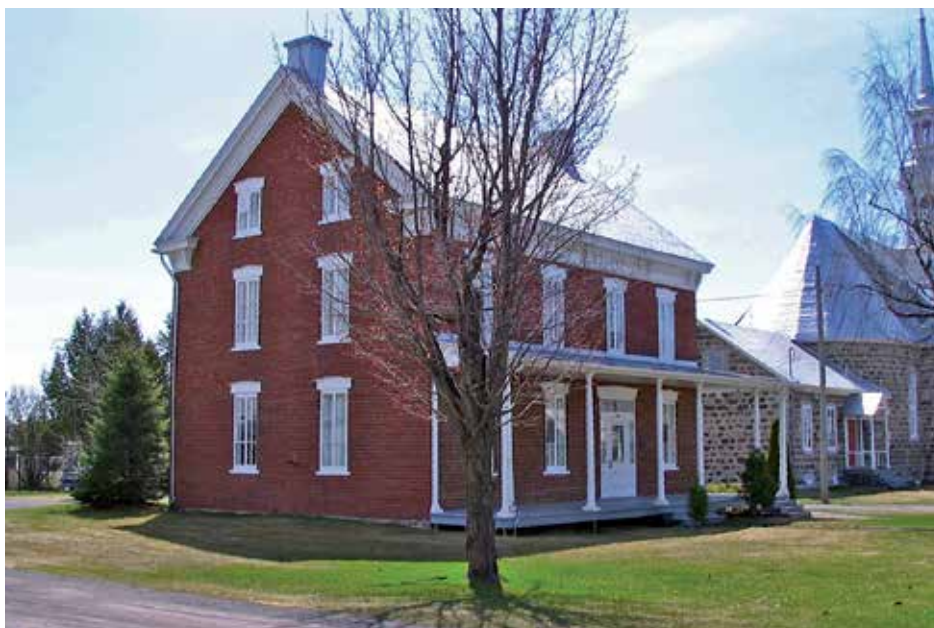
La maison de curé de Sainte-Mélanie, dans Lanaudière, s'inscrit dans le style vernaculaire américain, qui se caractérise notamment par un étage élevé permettant de se dispenser de lucarnes.
