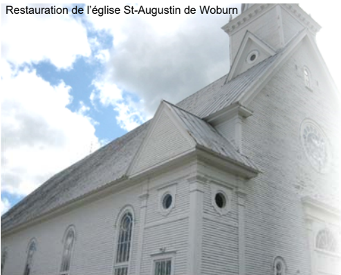
Restauration de l'église St-Augustin de Woburn
