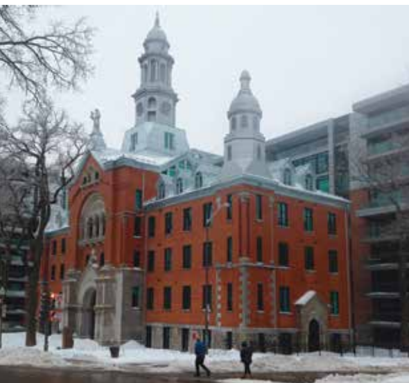
La chapelle des Franciscaines missionnaires de Marie a été reconstruite et intégrée à L'Étoile, un immeuble de 240 logements en copropriété.
