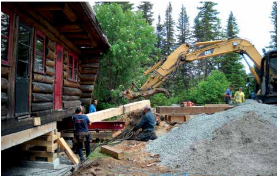
La structure étant plus détériorée que prévu, il a fallu soulever l'ensemble du bâtiment.
