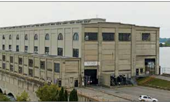
Hydro-Québec mène actuellement un projet de réhabilitation de la centrale des Cèdres.
