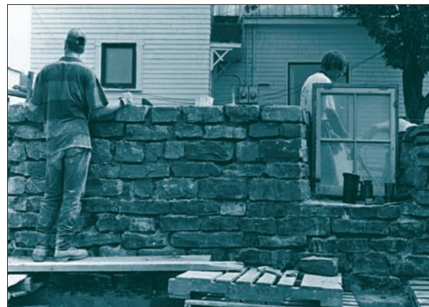
Des maçons montent un mur de pierre.
