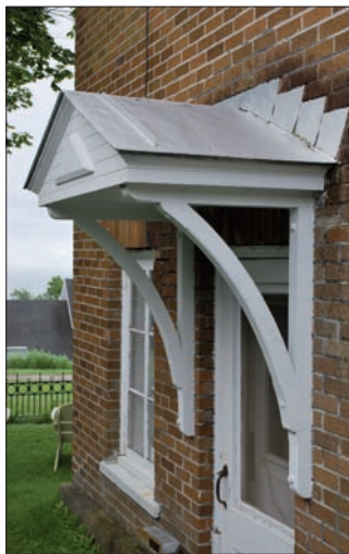
Un revêtement de toiture et des solins bien entretenus assureront une bonne durée de vie à la marquise.
