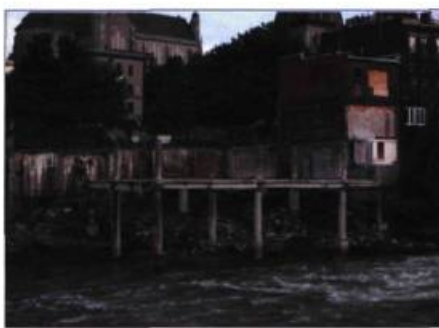
L'édifice Gabr a été démolit et les piliers sur la rivière Magog ont été enlevés pour faire place au projet.
