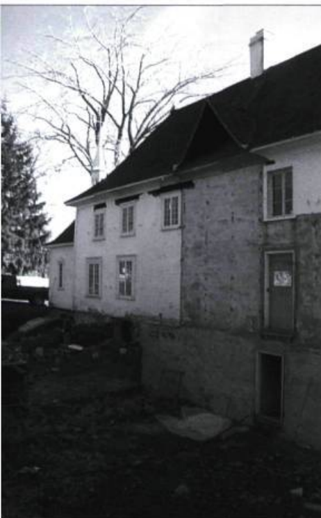
L'arrière du manoir Mauvide-Genest avant qu'on y construise un ajout qui offre les accès publics requis par la nouvelle vocation du bâtiment.
