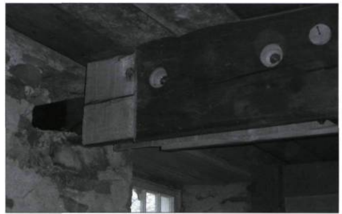
La structure s'étant passablement dégradée au fil du temps, il a fallu, lors de la restauration, mettre des étriers métalliques dans la maçonnerie pour renforcer les poutres.
