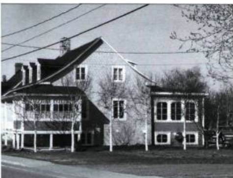
À l'arrière de la maison, un agrandissement qui respecte les proportions du bâti existant.
