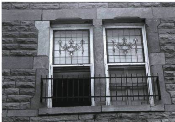
En ville, le châssis supérieur de la guillotine est souvent orné d'un vitrail.
