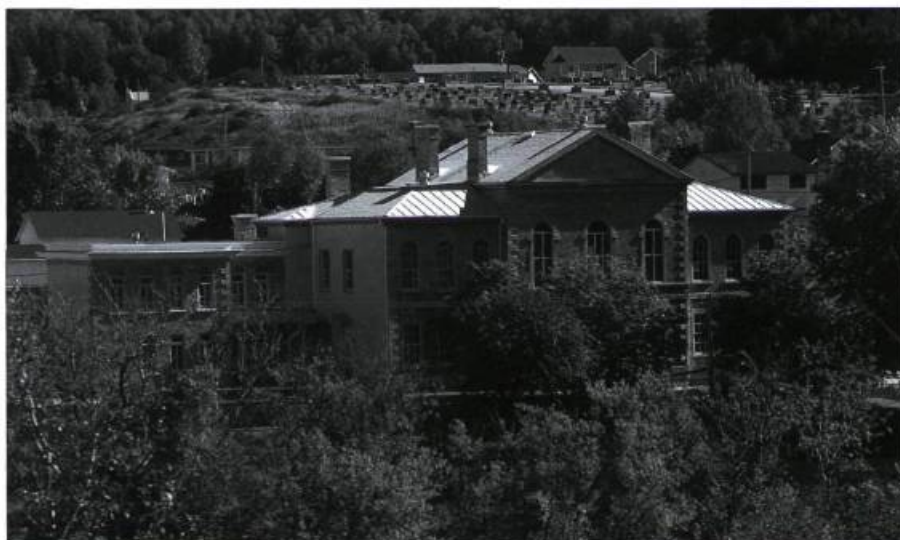
Le palais de justice de La Malbaie est le seul édifice public érigé sur le territoire de Rivière-Malbaie. Cette construction en pierre de taille est l'une des mieux conservées au Québec.
