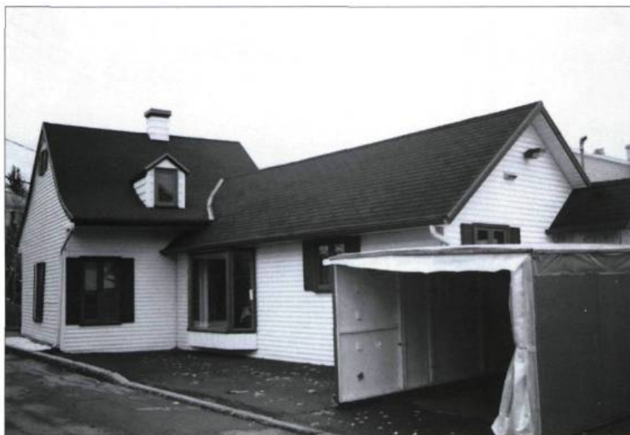
À l'arrière d'une maison ouvrière du Vieux-Sillery, un agrandissement bien peu esthétique.
