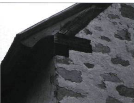
Détail d'un coyau qui donne au larmier son galbe et assure sa protection.
