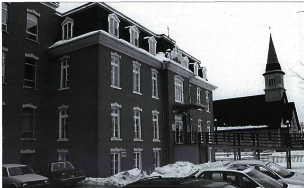
Après le couvent Saint-Isidore à Montréal, c'est maintenant au tour du couvent de La Malbaie d'être menacé de démolition...
