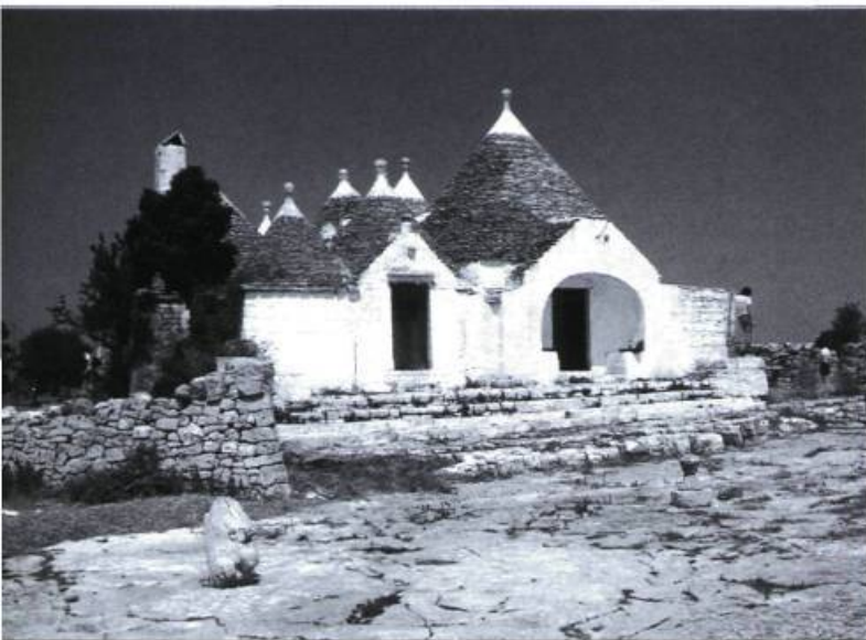
Les maisons Trulli en Italie du Sud sont un exemple de constructions où on réutilise d'anciennes pierres.
