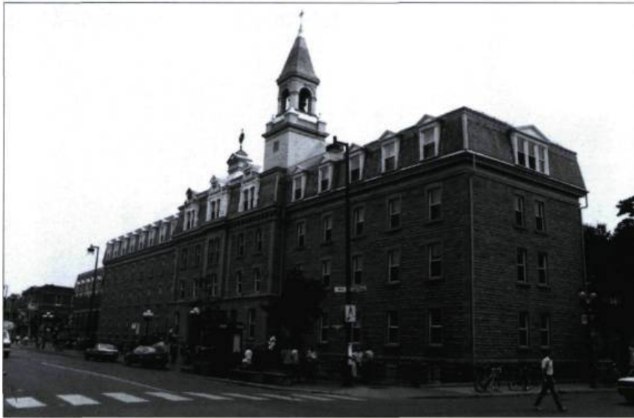
Le monastère de l'ensemble conventuel des Pères du Très-Saint-Sacrement pourrait accueillir la Maison de la culture.
