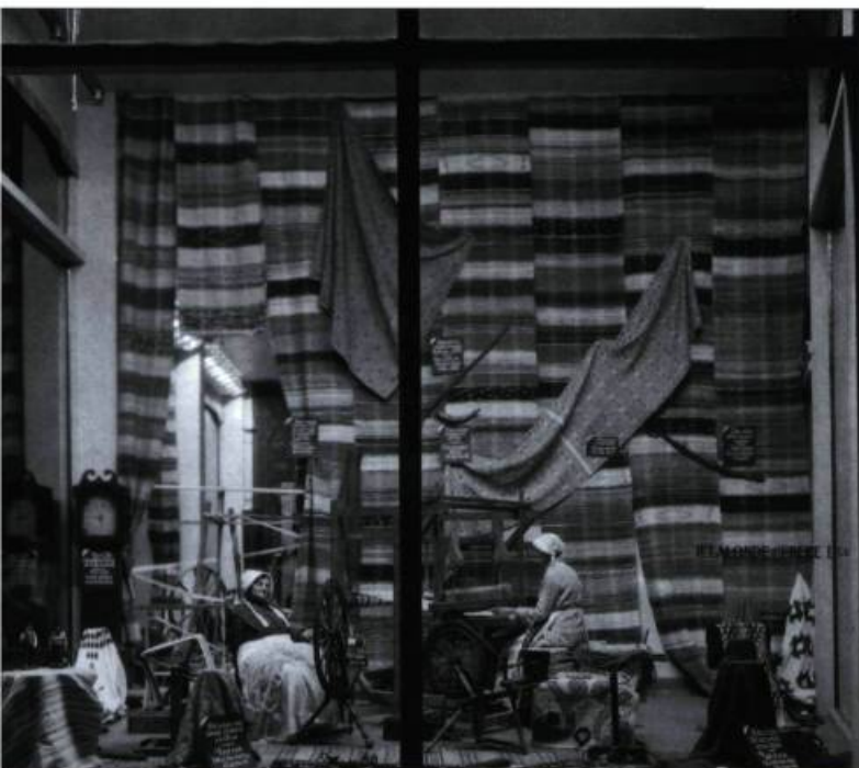
L'édifice H. Lalonde & Frères abrite la plus vieille maison de spécialistes de tapis au Canada. Érigé en 1928 par les architectes Lapierre & Dumfries, l'immeuble présente en devanture d'immenses vitrines qui constituent une véritable attraction pour le passant.
