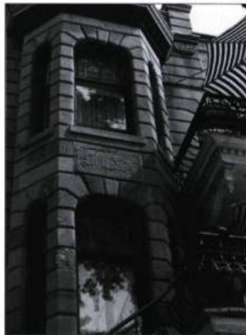
Détail de la maçonnerie de pierre et du couronnement de cuivre de la corniche d'un édifice résidentiel de la rue Saint-Hubert.
