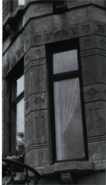
Motifs en relief dans la taille de la pierre. Dans les constructions moins prestigieuses, ce décor aurait été réalisé en bois.
