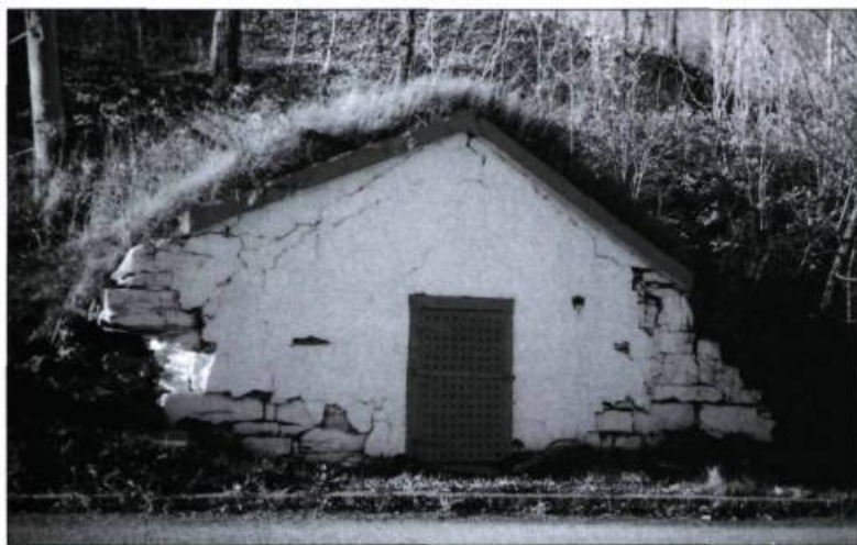
On retrouve une forte concentration de caveaux à légumes dans la partie est de la paroisse de Château-Richer, certains encore en utilisation. Photos : R. Laberge
