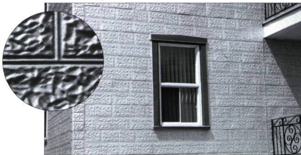
Revêtement de tôle d'origine qui imite la pierre de taille à bossage et un gros plan d'une feuille de tôle où l'on peut même voir les joints ronds en saillie.
