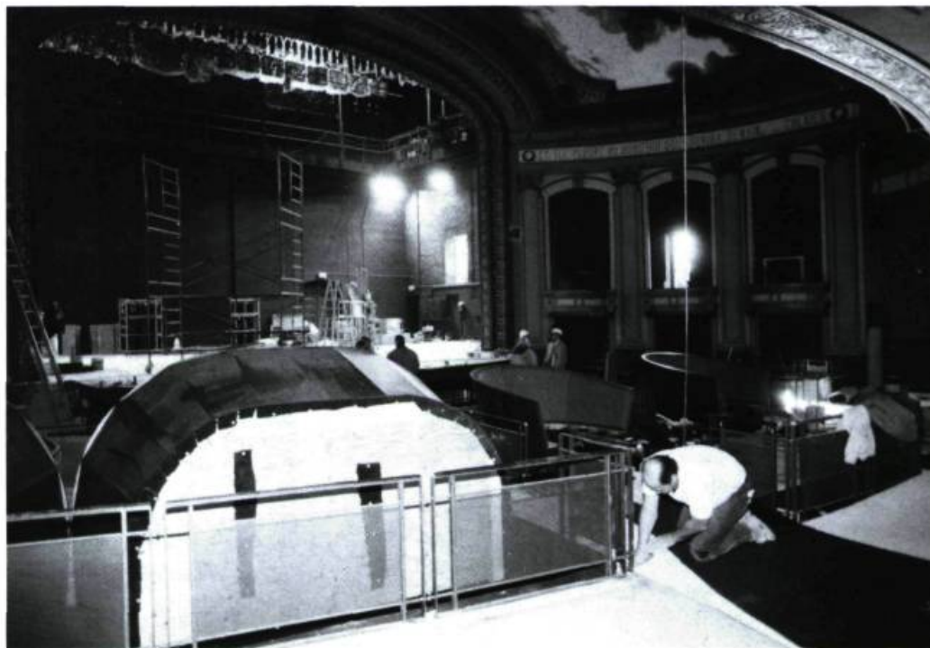
Une idée de l'ampleur des travaux dans la salle de spectacle.
