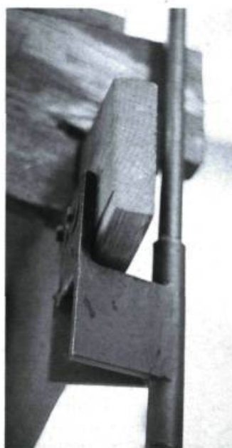
Détail du système d'accrochage de l'escalier. Photo: Pierre D'Anjou.
