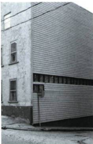
Au Québec, les murs les plus exposés aux intempéries et aux vents froids dominants étaient recouverts d'un déclin de bois appliqué sur un fond de clouage. On parvenait ainsi à isoler davantage le mur de maçonnerie. Photo: François Varin.
