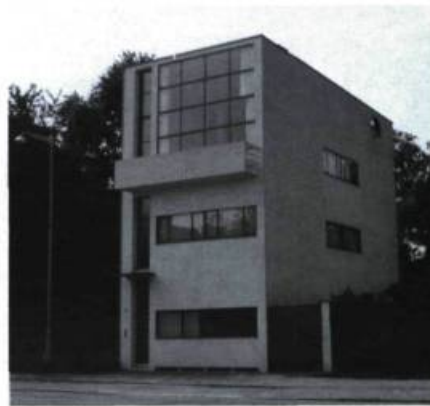
La maison Guiette (1927), à Anvers, conçue par Le Corbusier et restaurée par l'architecte Georges Baines. Photo: Coll. particulière.
