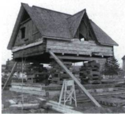
À la suite de son classement en 1978, la maison a fait peau neuve. On a dû démonter la structure du rez-de-chaussée et remplacer quantité de poutres. (photo: Société d'histoire du Témiscamingue)
