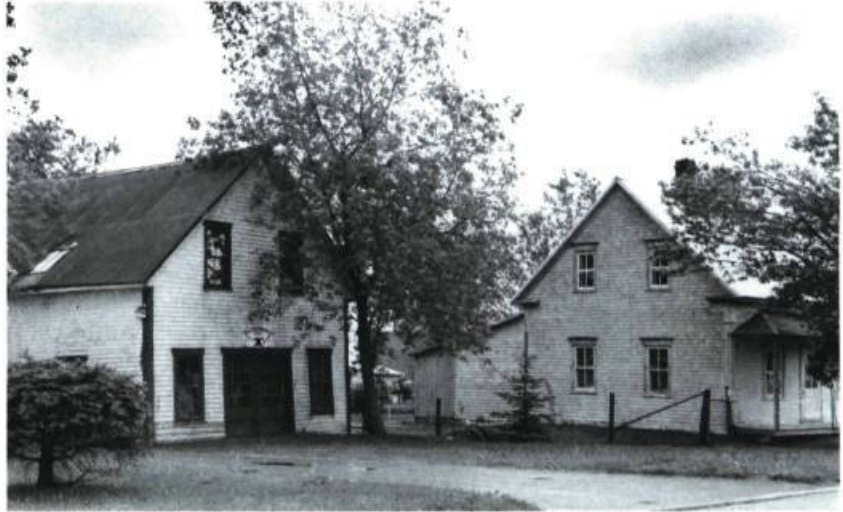
L'ancienne boutique de forge. (photo: Continuité)
