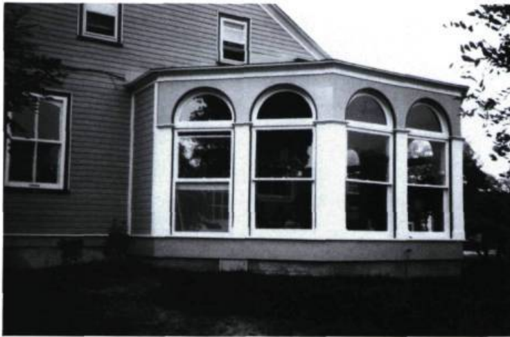
Exemple contemporain de véranda construite avec les mêmes matériaux que le bâtiment. Les détails architecturaux s'inspirent de ceux qu'on retrouve en façade. (photo: F. Varin)
