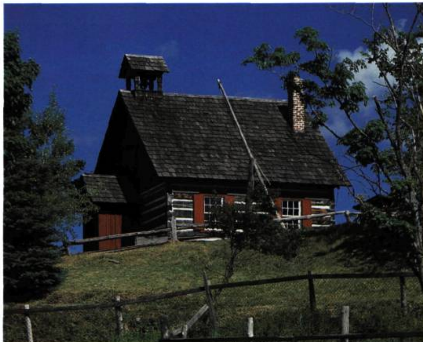
Au sommet d'une colline se dresse l'école de rang (1835), une solide construction en pièce sur pièce qui provient de Lakefield dans l'Outaouais. (photo: B.Ostiguy)
