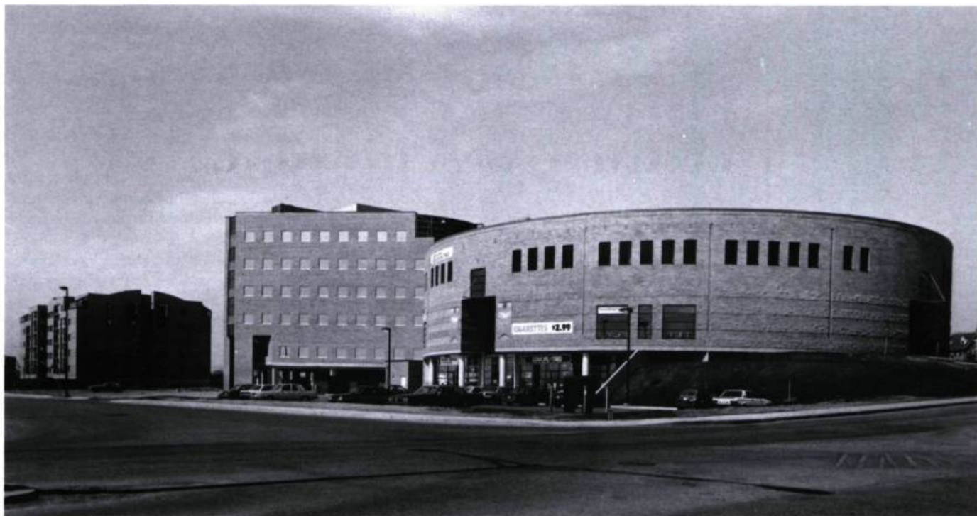
Le marché Quatre-Saisons à Charlesbourg (1987, Boutin et Ramoisy, arch.). La forme circulaire de l'édifice obéit moins à une rationalité fonctionnelle qu'à la volonté d'étonner. (photo: B. Ostiguy)
