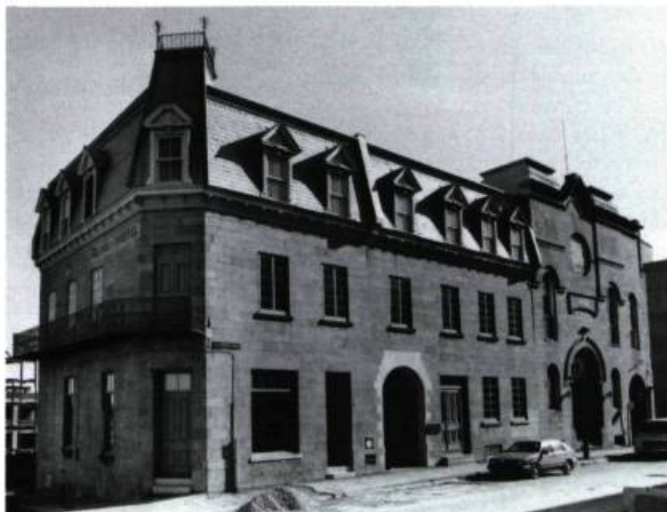
Construite entre 1836 et 1838, la maison de la rue Notre-Dame est acquise par George-Étienne Cartier en 1862. Le toit mansardé date de 1893. (photo: B. Ostiguy)
