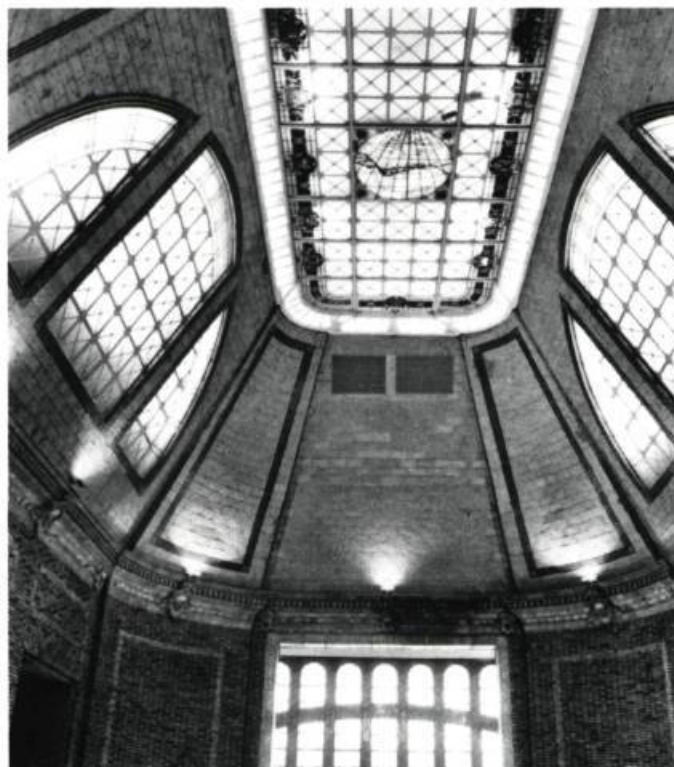
Le hall est baigné de lumière grâce aux puits en verre plombée de la toiture. (photo: B. Ostiguy)
