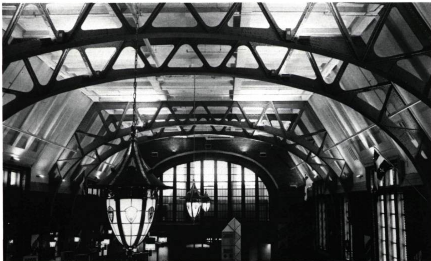
Les grands arcs d'acier en anse de panier sont utilisés tant pour leurs valeurs fonctionnelles qu'esthétiques. (photo: B. Ostiguy)
