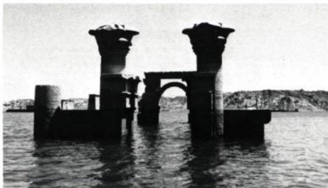
Depuis la construction du premier barrage d'Assouan en 1902, et surtout depuis la mise en service du haut barrage en 1970, ce monument de l'île de Philae se trouvait soumis à l'érosion constante des eaux du Nil. (photo: D. Roger, Unesco)
