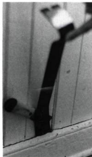
7. Le pied-de-biche sert à détacher graduellement la moulure. Pour protéger le mur, on utilise un morceau de bois ou un couteau à mastic, qui empêche le fer courbé de marquer le bois. (photo: F. Varin)
