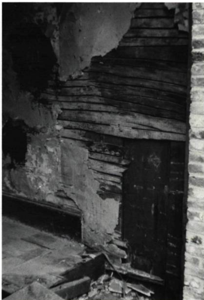
1. Lattes fendues à la hache, clouées à la charpente afin de recevoir un crépi de chaux. (photo: F. Varin)
