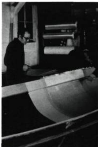
4. Le débullage. Sous l'oeil attentif de son père, Richard Bégin enlève les bulles d'air à l'aide d'un débulleur, assurant ainsi l'osmose des matériaux. (photo: S. Drolet)
