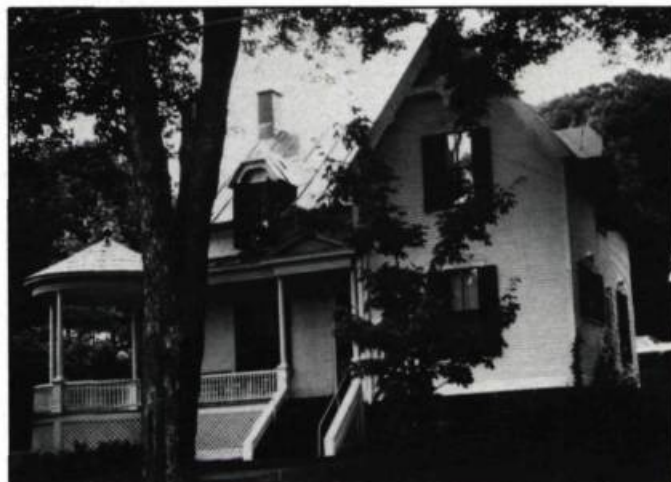
Érigée en 1894, la maison Garneau témoigne du «style néo-gothique».
