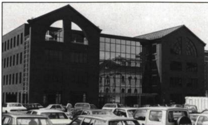
L'addition à l'édifice John Munn tire avantage de sa situation à la limite du quartier Saint-Pierre et du site du Vieux-Port: l'expression architecturale différente des façades sur la rue Dalhousie et sur le site (photo) offre une bonne transition d'un milieu à l'autre. (photo: F. Lachapelle)
