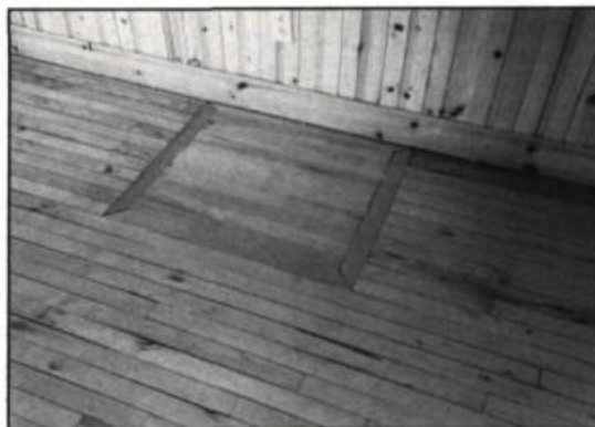
8. Ancienne trappe condamnée menant à la cave. La conservation de ce témoin physique rappelle une partie de l'histoire du bâtiment. (photo: F. Varin)
