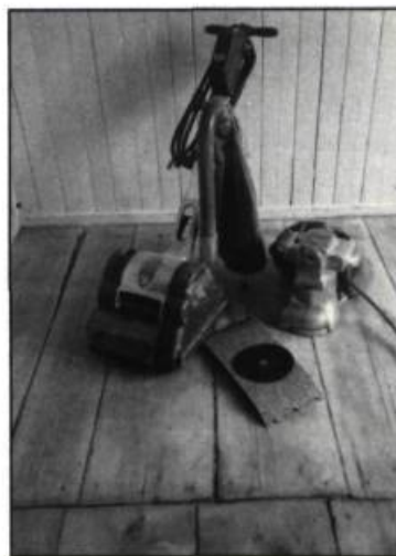
10. Les deux appareils utilisés pour sabler les planchers: celui à tambour s'emploie pour les grandes surfaces et celui circulaire, le long des murs et les endroits moins accessibles. À côté, les deux types de papier sablé fin que l'on peut utiliser. (photo: F. Varin)
