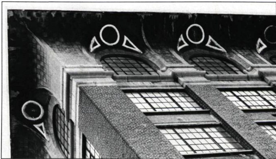
Le Unity Building situé au 454, rue de la Gauchetière dans le Vieux-Montréal. Seuls éléments de décoration, les motifs Art nouveau donnent du dynamisme à l'ensemble. (photo: F. Lachapelle)
