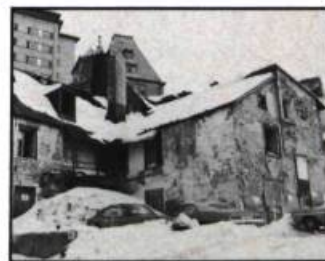
Les annexes (à droite) récemment démolies à l'arrière des maisons de Guise dit Flamand et McKenzie. (photo: Parcs Canada)
