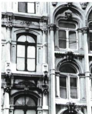
Décor fin de siècle en pierres de taille bouchardées, ciselées et sculptées.
