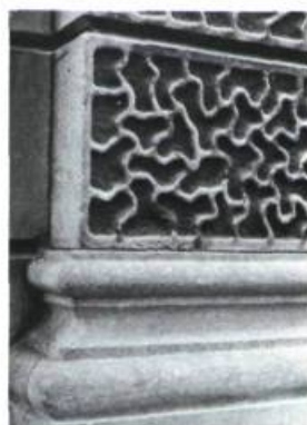
12 Une base de pilastre en pierres taillées moulurées et départ d'un pilastre en pierres taillées au décor vermiculé.
