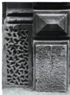
11B Bel exemple d'harmonie entre plusieurs tailles décoratives. À gauche, une pierre taillée dont les arêtes sont relevées au ciseau et une face dite «vermiculée» pour imiter les traces laissées par les vers. À droite, deux pierres de
