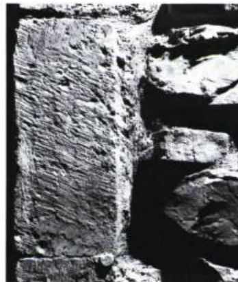
10 Pierre de jambage de la redoute Dauphine au Parc de l'Artillerie, à Québec. À remarquer les ciselures à l'oblique laissées par l'utilisation du ciseau et les trous par le pic.
