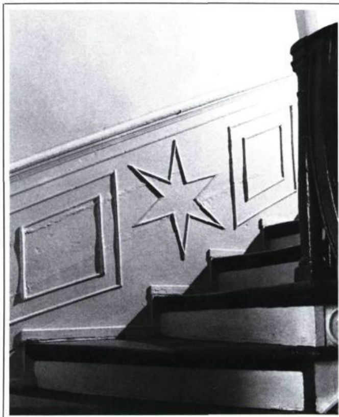
Lambris à mi-hauteur ornant l'escalier de la maison Leboeuf (ca 1780).
