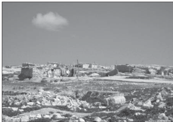
Figure 6 Quelques habitations précaires dans le quartier périphérique de Beïda Seghira à Aïn-Beïda
