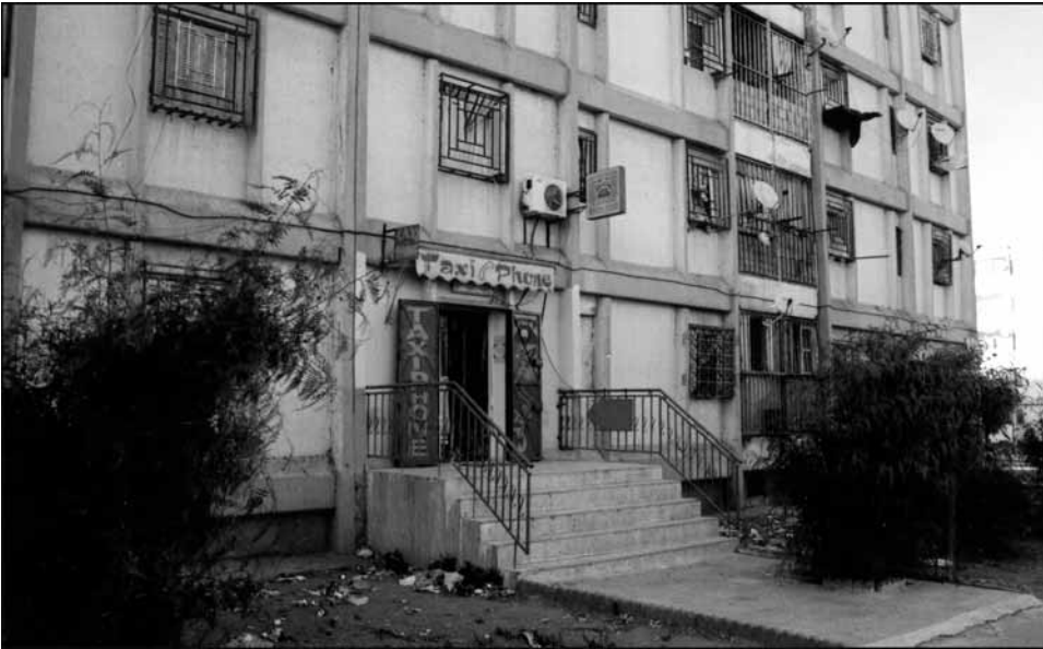
Figure 2 Déspécialisation partielle du logement à l'arrière d'un immeuble à Maraval, banlieue sud d'Oran
