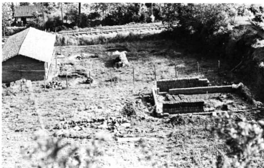
PHOTO 4 Une voie ferrée et une ligne à haute tension traversent San Miguel, mais aucun train ne s'y arrête et il n'y a pas d'électricité. L'emprise de la voie ferrée sert plutôt de promenade aux résidents. Presque toutes les constructions sont « en dur », mais on continue d'utiliser la brique crue (adobe) pour les annexes.
