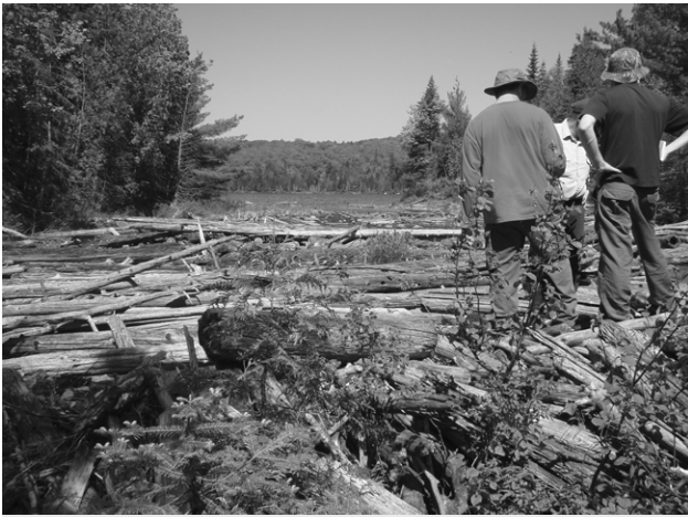
Décharge du lac Reid avant les travaux de restauration écologique. Présence de vestiges d'un barrage de drave et accumulation de bois tombé après l'enneigement des rives. (Source : Parcs Canada).
