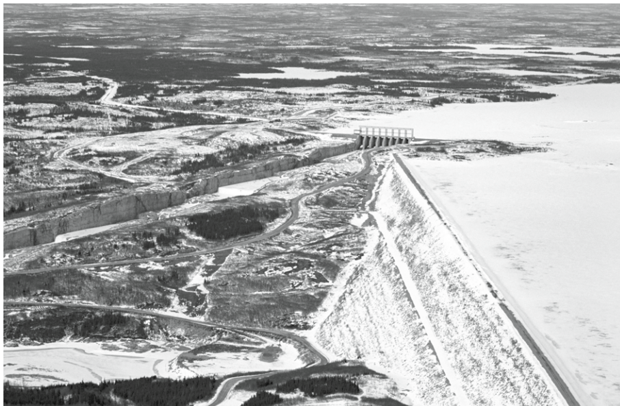
Aménagement Robert-Bourassa et évacuateur de crues la Baie-James. (Photo : Pierre Lahoud, 2000).
