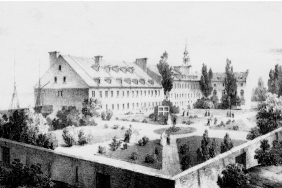
Les communautés religieuses, comme les hospitalières de l'Hôpital Général de Québec, se retrouvent avec un grand nombre de papiers du Canada pour fournitures de vivres et soins. Cette question les affectera grandement après la signature du traité de Paris. Vue du Monastère de l'Hôpital Général de Québec, à Notre Dame des Anges. Lithographie de François D'Avignon (1855), d'après un daguerréotype de Léon-Antoine Lemire. (Collection Yves Beauregard).
